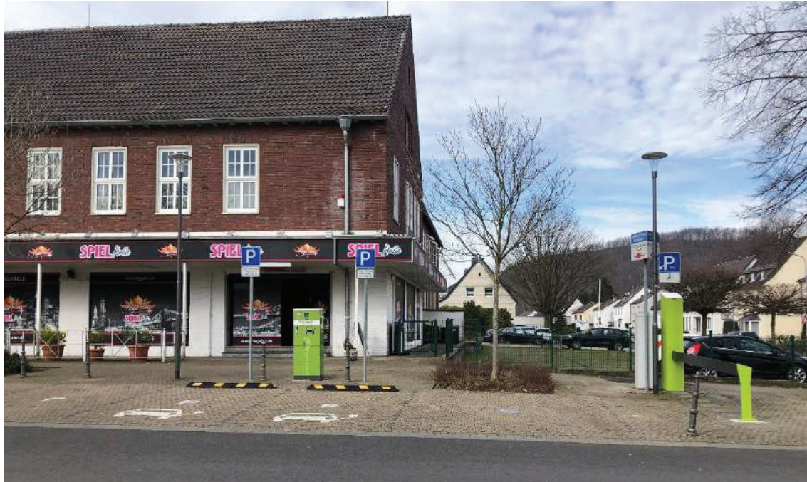
Abb. 4.2-1 E-Ladestation August-Schmidt-Platz in Herzogenrath (Eigene Aufnahme)
