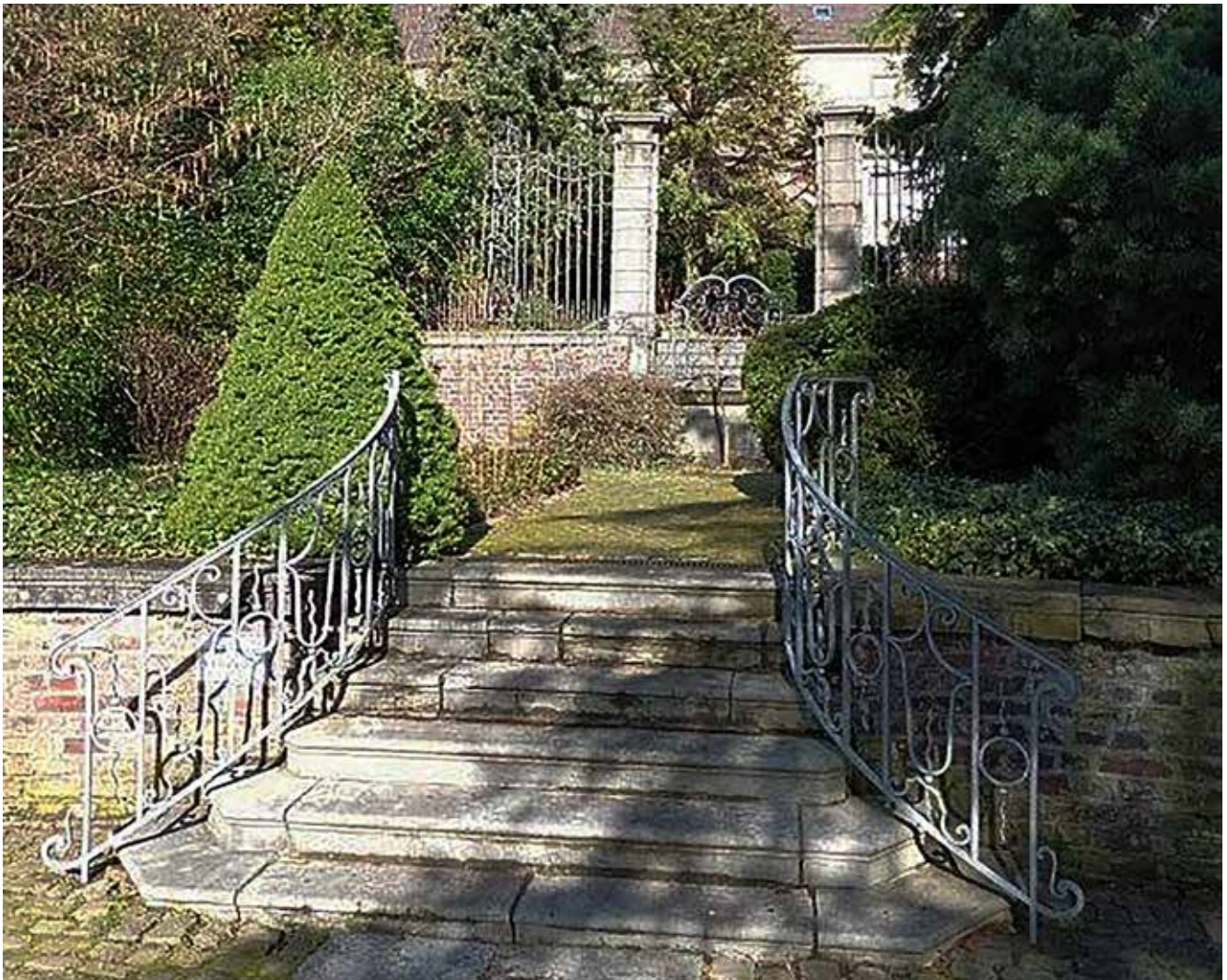
Baudenkmal, Blick Richtung Norden
