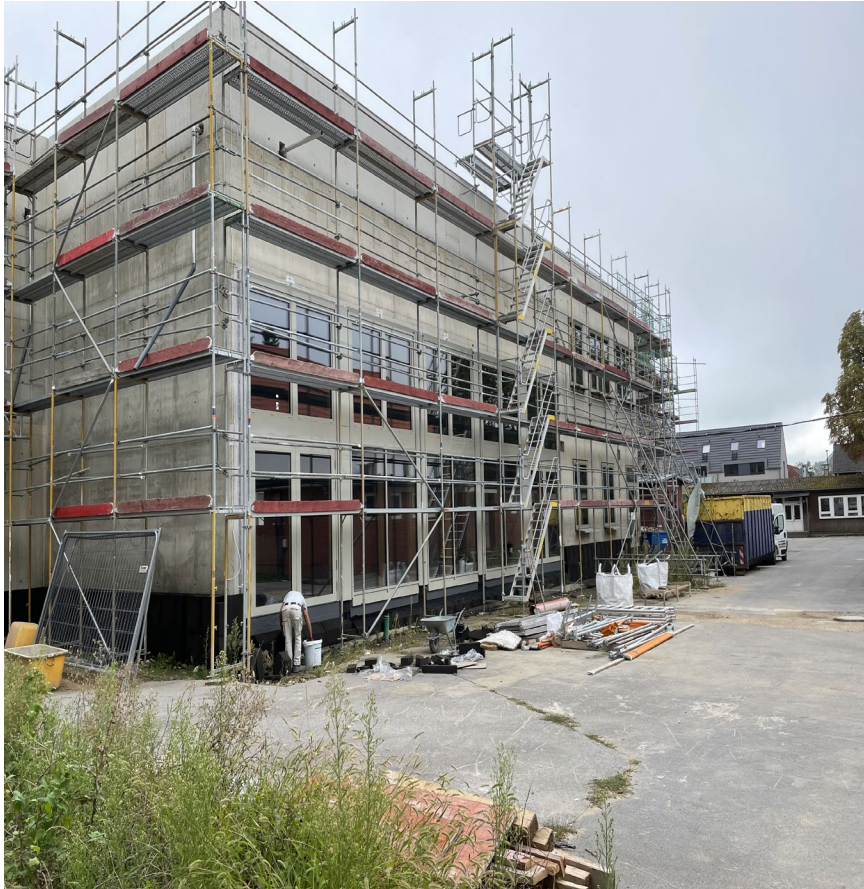
Baustellenfotos Bauteil B
