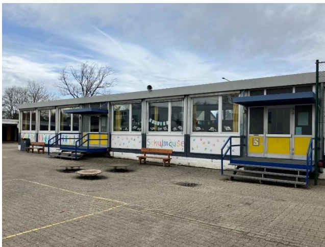
Pavillon mit Räumen für den Ganzttag
