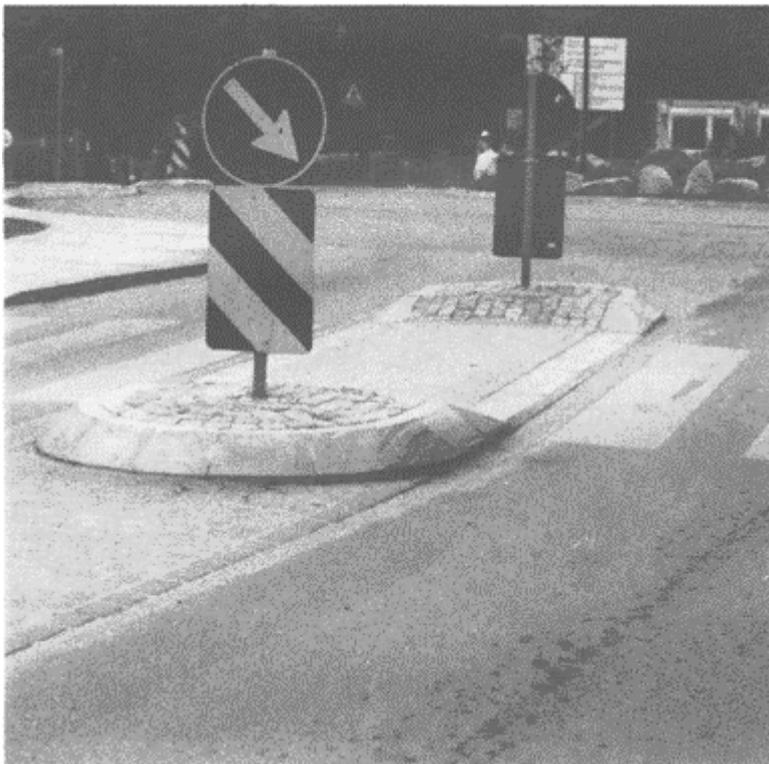
Bild1: Beispiel für eine Fußgängerführung in der Zufahrt zu einem Kreisverkehr
