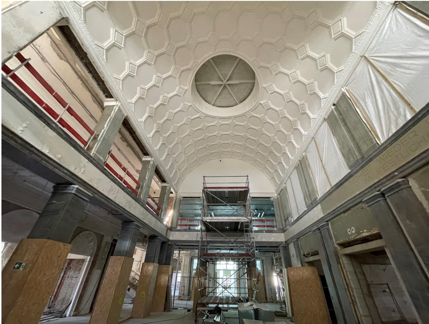
Restaurierung Deckentonne „Vestibül“
