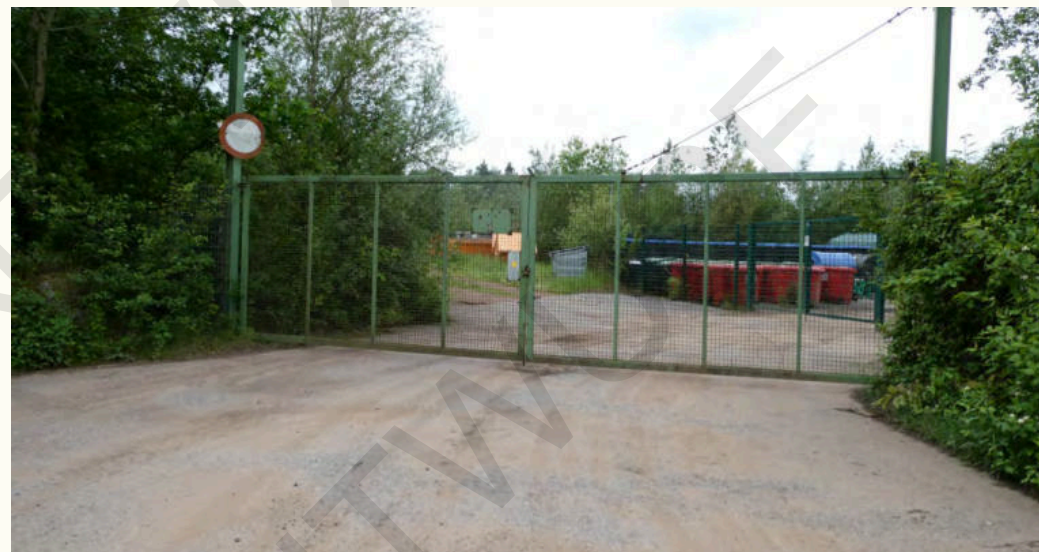
Abb. 123: Bislang für die Öffentlichkeit unzugängliche Zufahrt zum Stadtbetrieb
