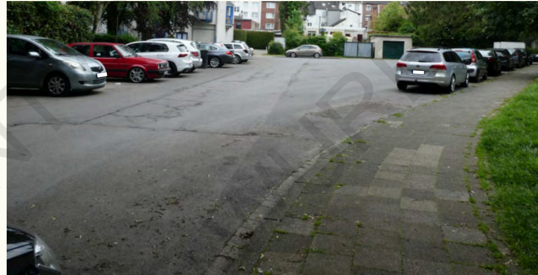
Abb. 118: Überdimensionierter Straßenraum II
