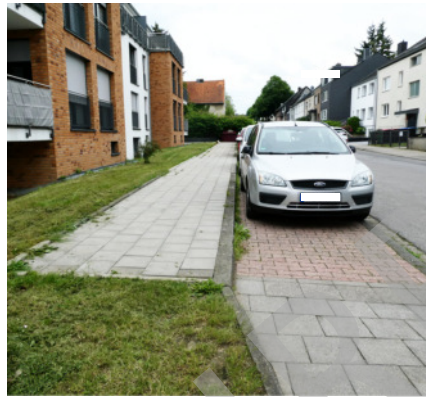
Abb. 14: Gehwegsituation entlang des Drosselwegs
