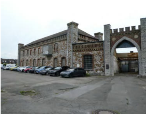
Abb. 80: Ehemalige Burg Schönforst
