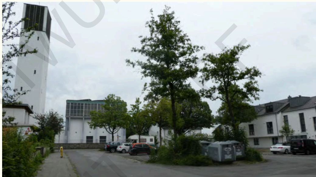
Abb. 133: Parkplatz am Pappelweiher und Auferstehungskirche
