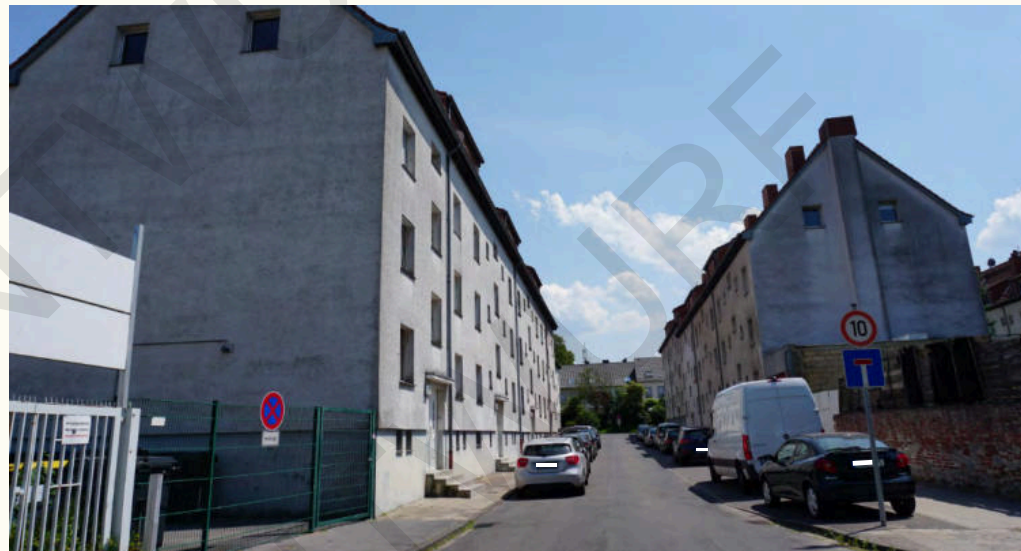
Abb. 201: Wohngebäude und Straßenraumgestaltung im Schönforstwinkel
