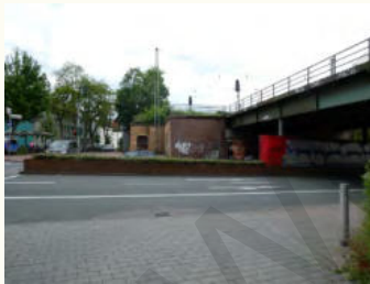
Abb. 126: Blick vom Vennbahnweg auf die Trierer Straße
