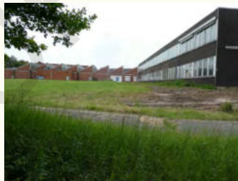
Abb. 193: Privater Freiraum und Gewerbegebäude der ehem. Burg Schönforst
