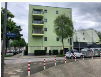
Abb. 101: Nördlicher Beginn der Mataréstraße
