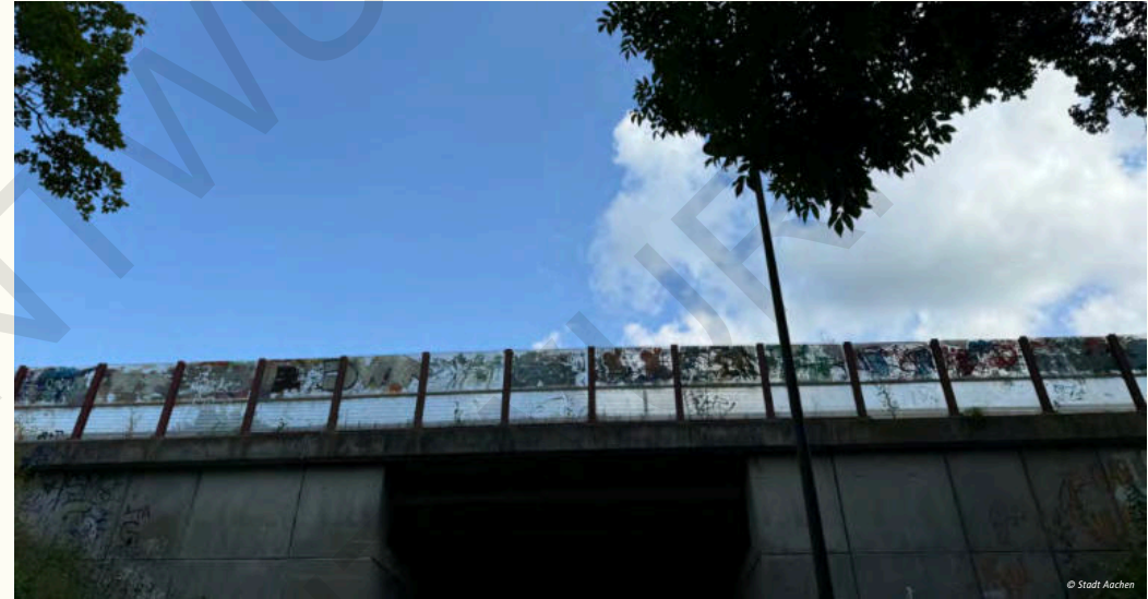
Abb. 234: Derzeitiger Lärmschutz zwischen der A 44 und dem Teilraum Driescher Hof
