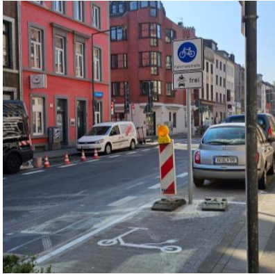
Templergraben 51 (Quelle: Stadt Aachen)
