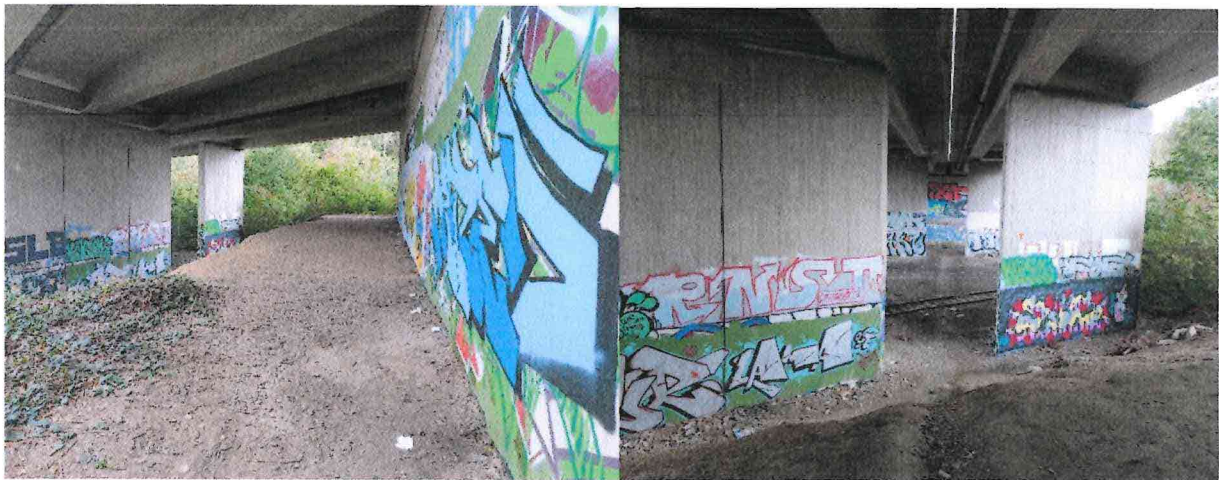
Abbildung 1 Oberer Ansicht der Vennbahnwegbrücke
