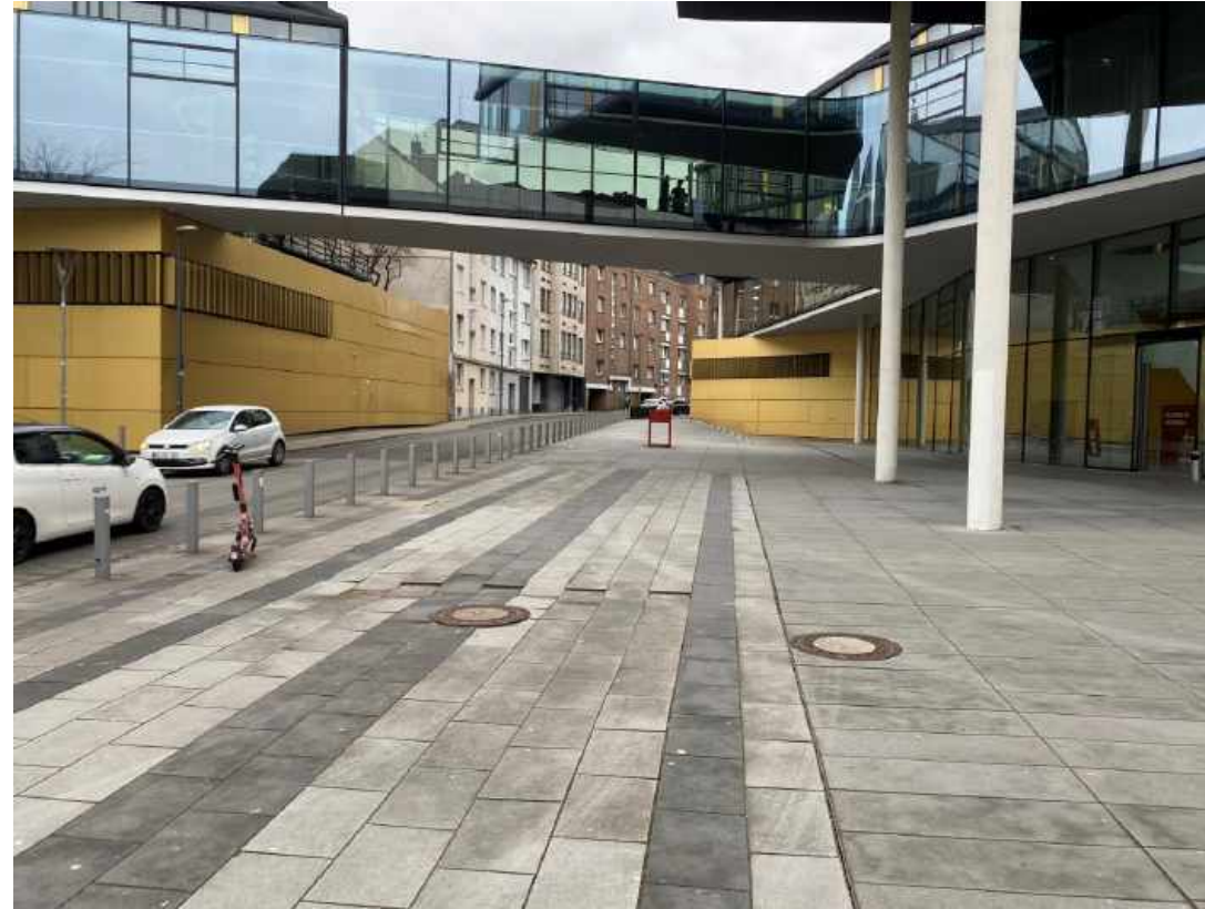
Aachen-Münchener-Direktionsgebäude, 2023 (Foto: F. Lohrberg)
