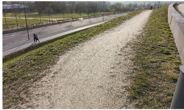
Abbildung 6: Ist-Zustand Rampe Sommerfeldstraße zur Forckenbeckstraße am Süden der Nord-Süd-Achse
