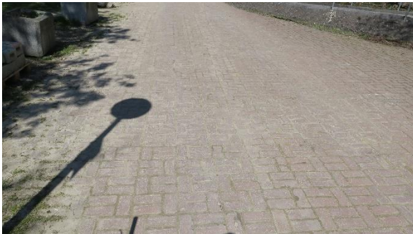
Abbildung 7: Ist-Zustand Mittlerer-Abschnitt Nord-Süd-Achse
