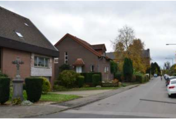
Einfamilienhäuser in Alt-Richterich
