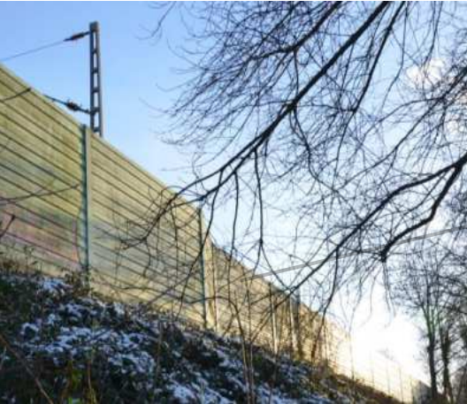
Schallschutzwand an den Bahntrassen
