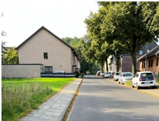
Abbildung 80: unterdimensionierter Gehweg in der Lindenstraße
