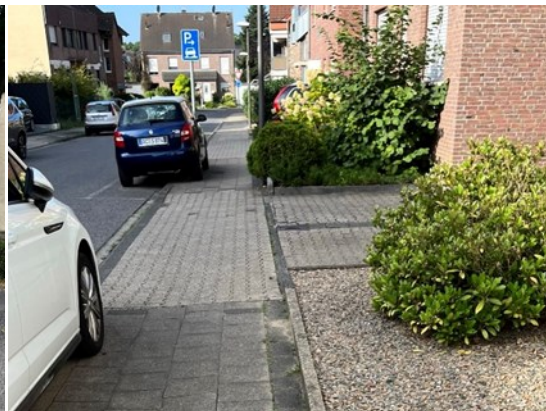
Abbildung 105: aufgeschultertes Parken (angeordnet) im Müselterweg bei geringer Restgehwegbreite
