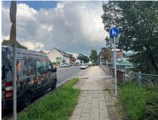
Abbildung 43: Ende der Freigabe des Gehwegs für den Radverkehr / fehlende Überleitung auf die Fahrbahn
