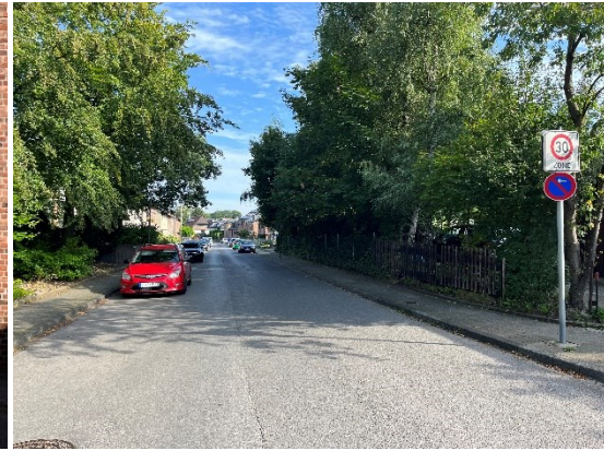
Abbildung 38: Unzureichende Gehwegbreiten in der Schubertstraße
