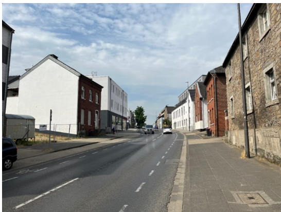
Abbildung 134: Von-Coels-Straße Höhe Hausnr. 222 Blickrichtung Außenring
