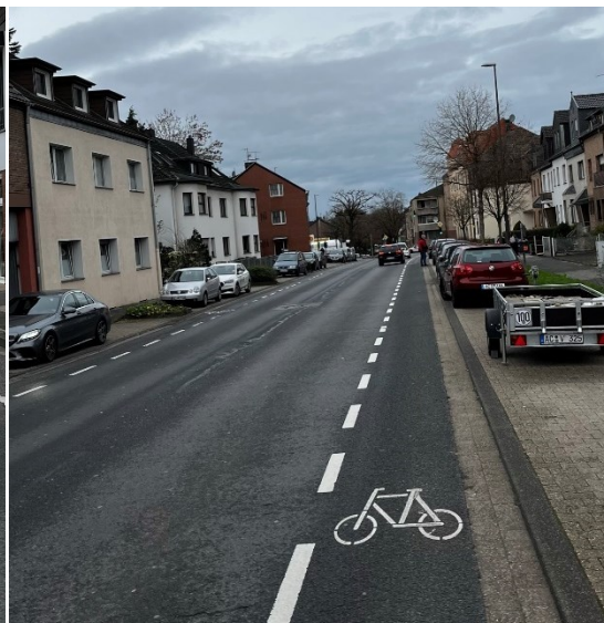
Abbildung 139: Von-Coels-Straße Höhe Hausnr. 34 Blickrichtung Außenring
