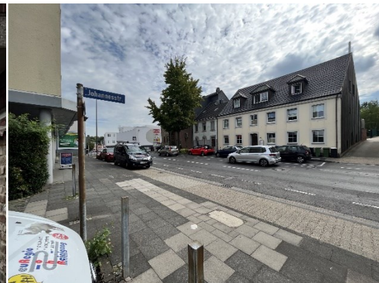
Abbildung 87: fehlende Querungsmöglichkeit im Bereich Johannesstraße/Von-Coels-Straße
