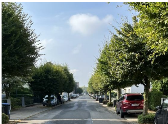
Abbildung 119: Unterdimensionierter Gehweg und unterdimensionierte Parkstände in der Karlstraße
