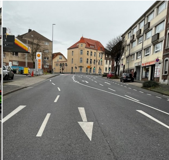
Abbildung 141: Von-Coels-Straße Höhe Hausnr. 4 Blickrichtung Eilendorf Markt
