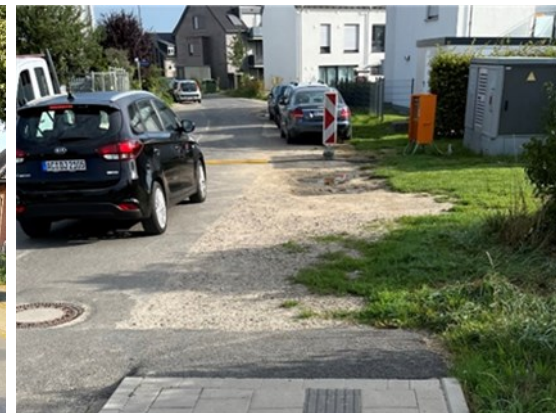
Abbildung 81: fehlender Gehweg in der Franz-Delheid-Straße
