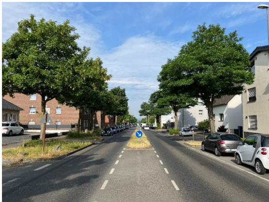
Abbildung 130: Von-Coels-Straße Höhe Hausnummer 444
