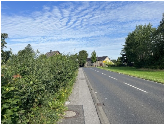
Abbildung 110: Ortseingang in Fahrtrichtung Eilendorf
