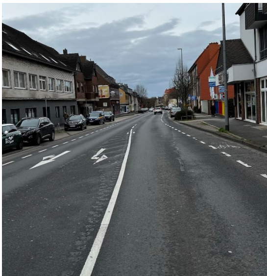
Abbildung 138: Von-Coels-Straße Höhe Hausnr. 54 Blickrichtung Außenring
