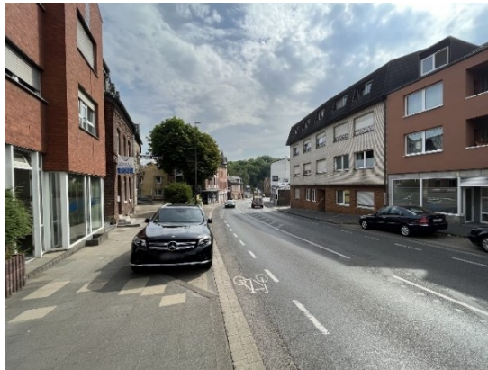
Abbildung 45: Fehlende Sicherheitstrennstreifen zwischen dem Schutzstreifen und dem ruhenden Verkehr an der Von-Coels-Straße
