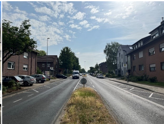
Abbildung 131: Von-Coels-Straße Höhe Hausnummer 352
