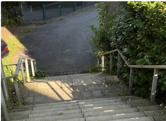
Abbildung 83: Treppenanlage zwischen der Severinstraße und dem Stollenweg
