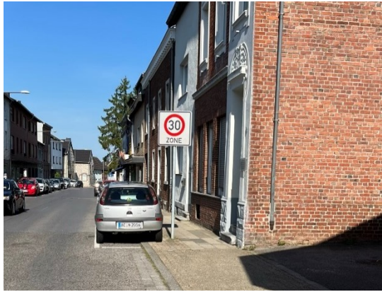
Abbildung 37: Unzureichende Gehwegbreiten mit zusätzlichem Hindernis in der Steinstraße
