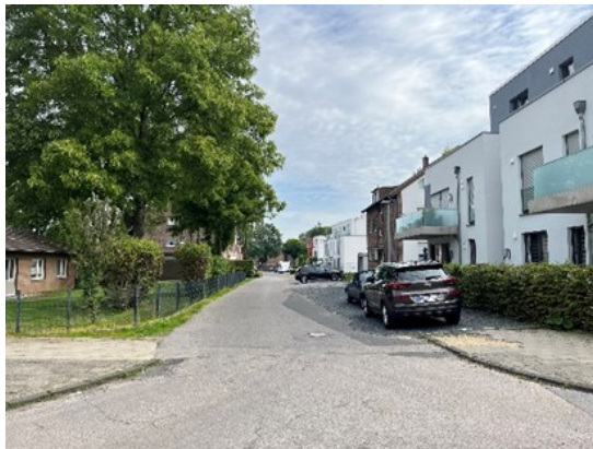
Abbildung 34: Fehrender Gehweg in der Urbanstraße
