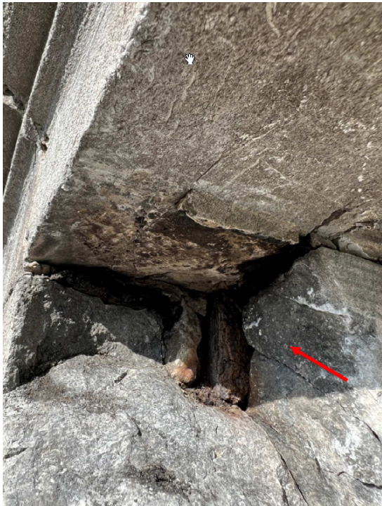
Rostende Metallteile (Dorne, Klammern, etc.)
