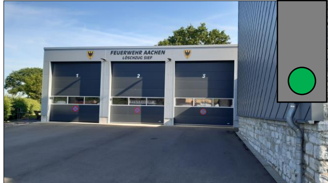
Abb. 42: Feuerwehrhaus LZ Sief
