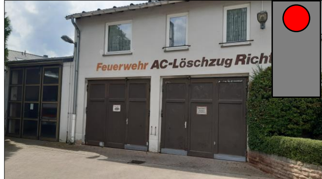
Abb. 32: Feuerwehrhaus LZ Richterich
