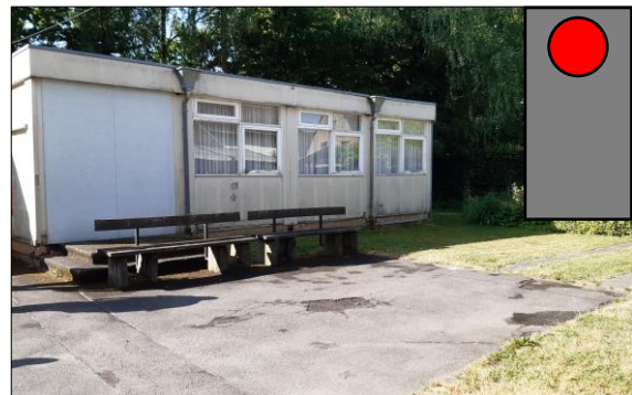
Abb. 41: Feuerwehrhaus LZ Walheim
