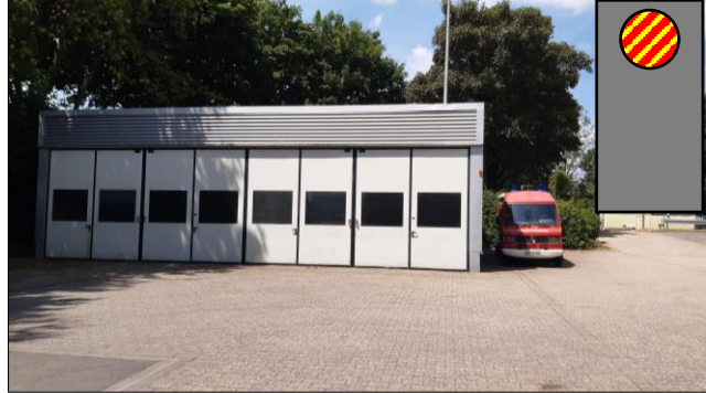
Abb. 44: Feuerwehrhaus Regieeinheit (auf Gelände der FW 3)
