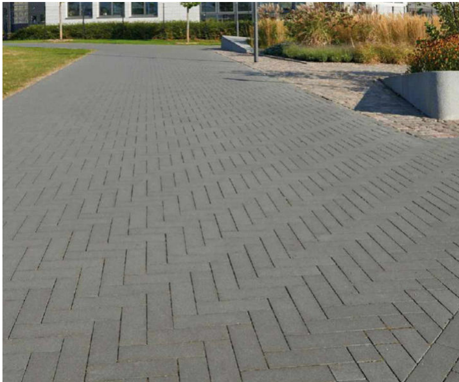
Plattenbelag, Betonstein (Abb. weicht vom Format ab)
