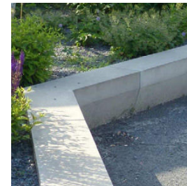
Mauer aus Betonelementen
