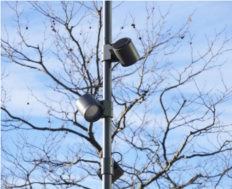
Wegeleuchte 1 Strahler / Masthöhe: 4,0 m 2 Strahler / Masthöhe: 5,0 m
