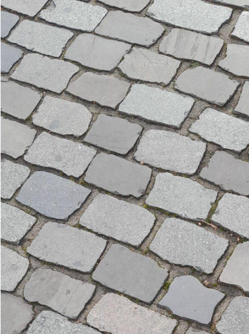
geschnittene Grauwacke, Wiedereinbau
