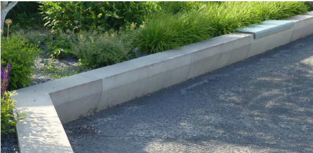
Mauer aus Betonelementen
