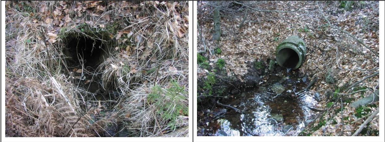
Abb. 5: Ist-Situation: links Sohlsprung beim Einlauf; rechts kl. Absturz beim Auslauf (Fotos: PBK, 24.02.2014)
