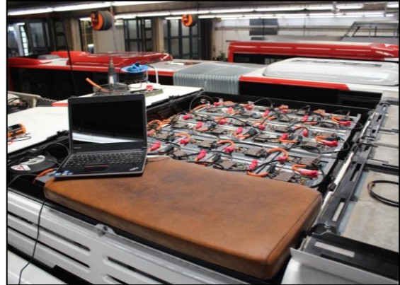
Der Blick auf das Dach nach dem Umbau
