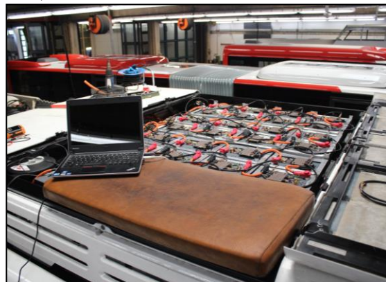
Der Blick auf das Dach nach dem Umbau
