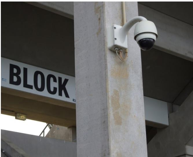
Die Stadion-Videoüberwachungsanlage im Tivoli wurde 2009 installiert und in Betrieb genommen. Die Anlage beinhaltet 32 schwenk- und zoombare IP-Kameras vom Hersteller Fa. Bosch, sowie einen Video-, Stageserver und 4 Videoarbeitsplätze mit je bis zu 4 Monitoren in der Polizei-Leitstelle zur Überwachung des gesamten Stadions.
