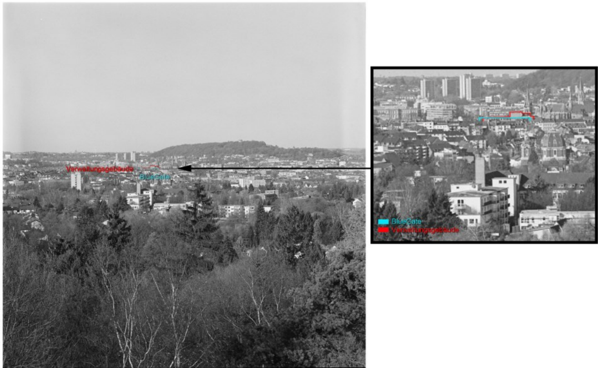
Abbildung 29: Blick vom Bismarckturm auf die Stadtsilhouette und Kennzeichnung des Vorhabens „BlueGate“
