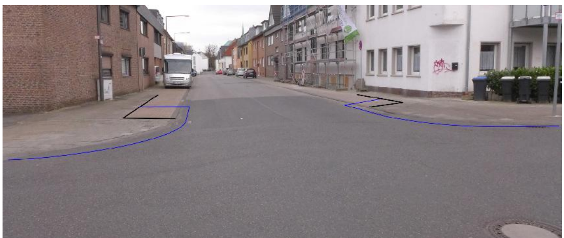
Bild 3 Parkstreifen Kaiserstraße (Abschnitt Karlstraße - Severinstraße). Gut erkennbar: die Kurvenausrundungen beginnen bereits unmittelbar hinter den rot gepflasterten Parkstreifen (schwarze Linien) und verdecken so die Sicht in die Kaiserstraße.
