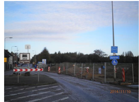
Gleicher Ort nach Abbruch (Okt. 2014)
