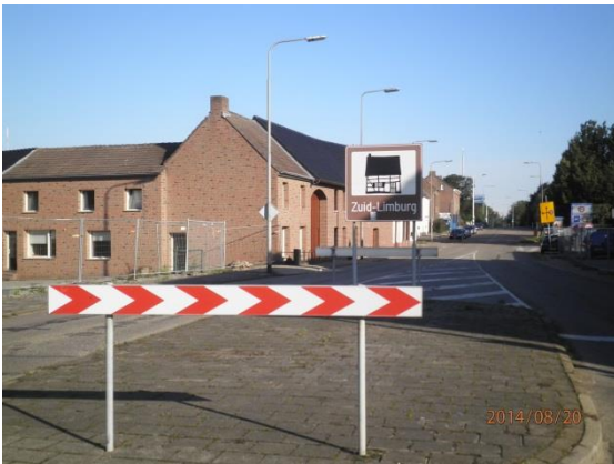
Grenzübergang Locht vor Abbruch der Gebäude
