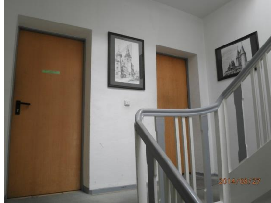
Erschließung durch das Treppenhaus
