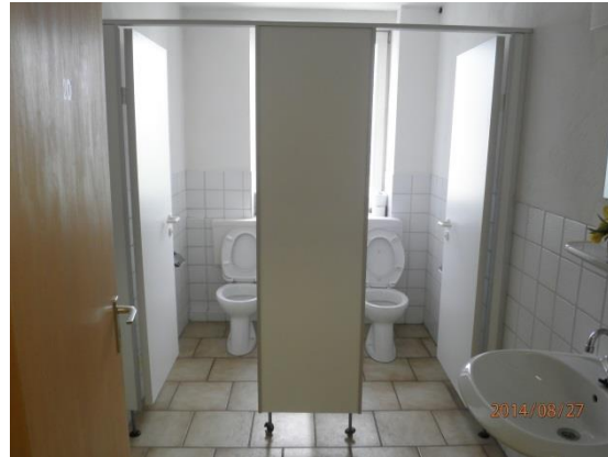
Toilette im Obergeschoss
