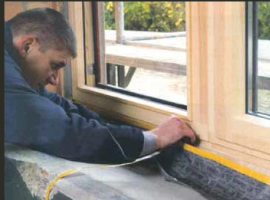
Fenstereinbau nach Regeln der Technik - Dichtheit
