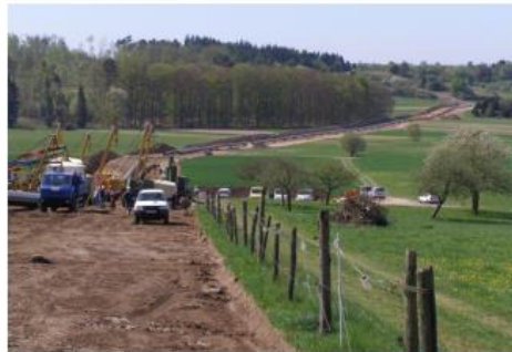
während des Leitungsbaus (Quelle: OGE)
