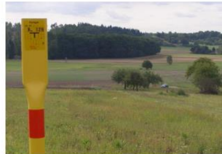
nach dem Leitungsbau (Quelle: OGE)
