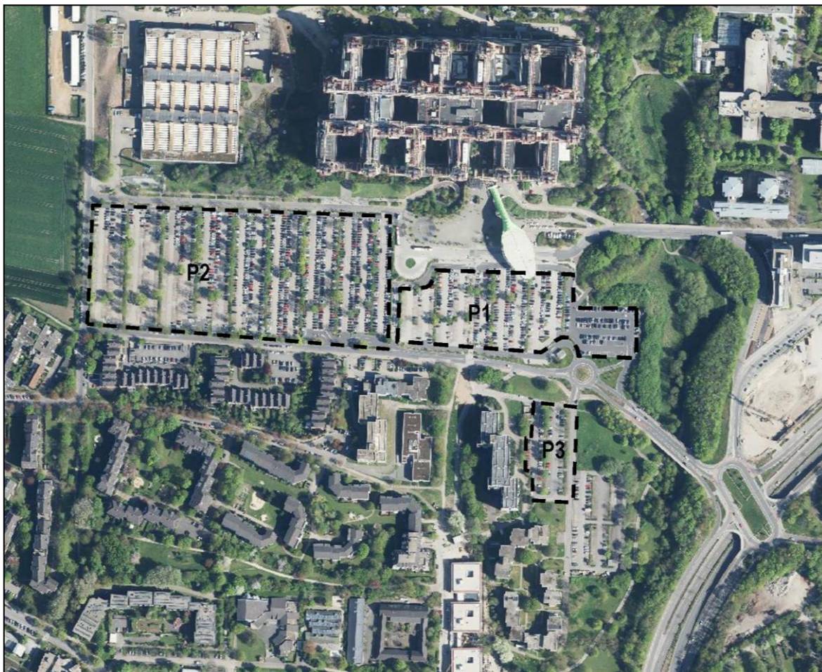
Abbildung 1: Plangebietsumfeld mit Stellplatzanlagen, [Quelle: Land NRW]
