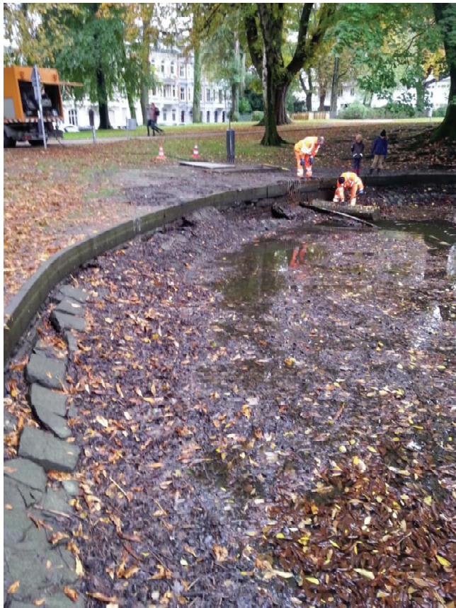
Fotos Ist-Zustand nach Ablassen des Teiches 2016
