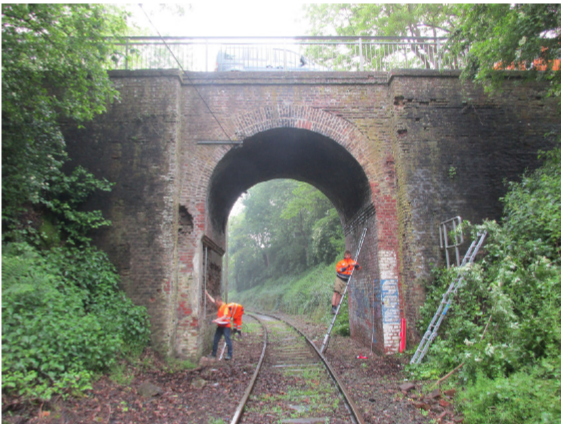
Ansicht aus Richtung Bf Aachen-Rothe Erde
