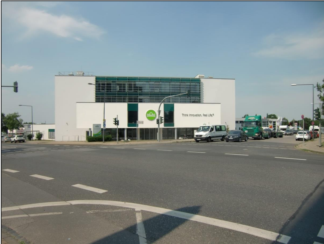
Einmündungsbereich Zieglerstraße/Neunhofstraße, Blickrichtung Zieglerstraße
