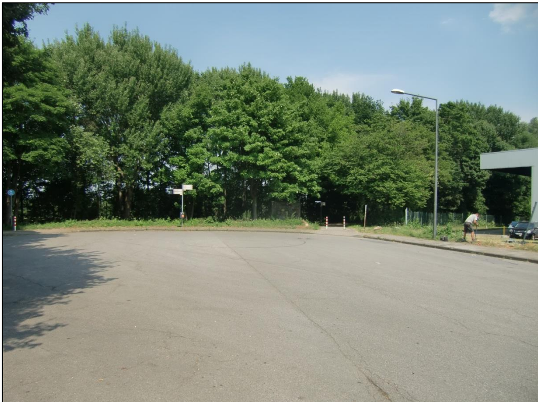
Wendehammer, Zuwegung zur Vennbahn
