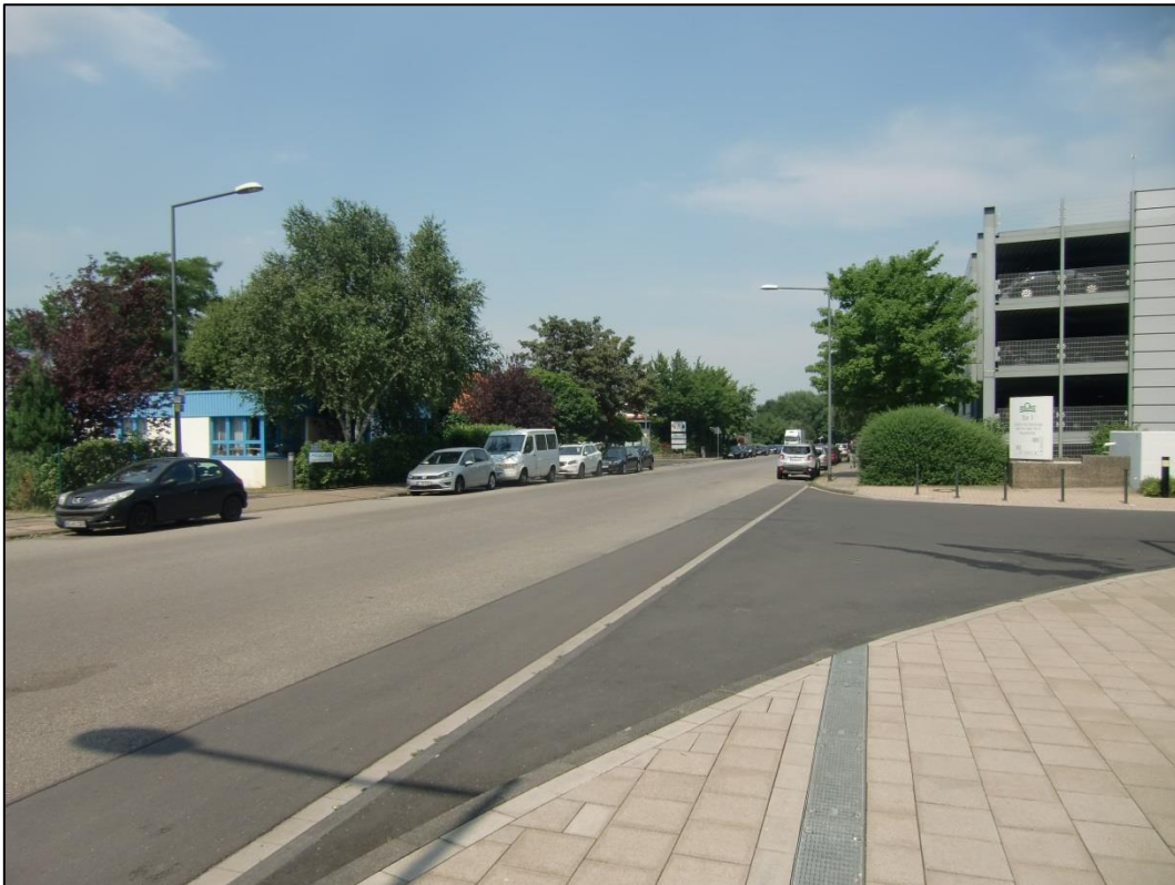
Zieglerstraße - Zufahrt zur Firma Grüenthal, Blickrichtung Kaubendenstraße
