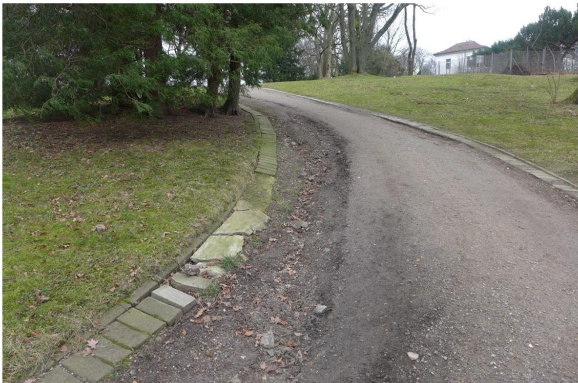
*Abb. 7: Beispiel für schadhafte wassergebundene Decke, Einfassung und Entwässerung außer Funktion*
