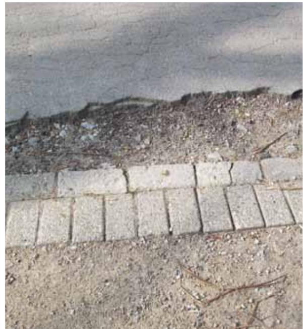
Abb.120 Unterschiedliche defekte Beläge im Stadtpark
