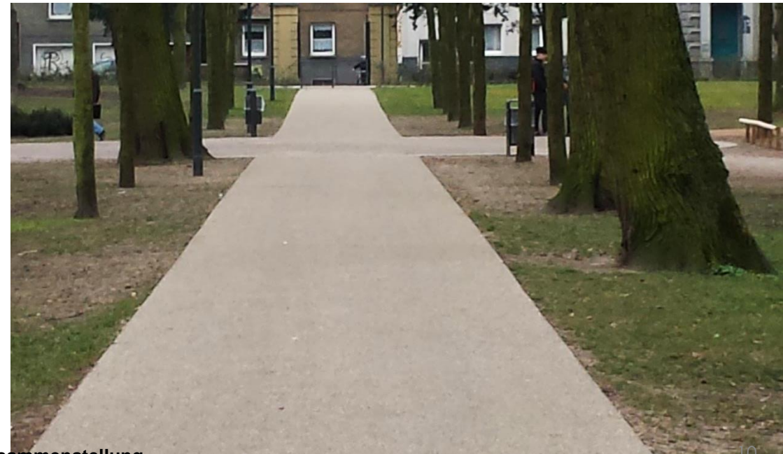
Beispiel für Wege (abgestreuter Asphalt) in einem Parkdenkmal
