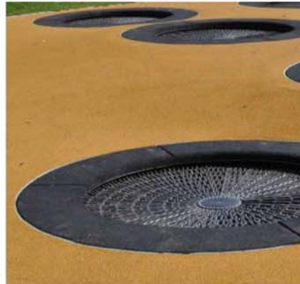
Trampoline (Sprungfläche Ø 1,30 m) mit Fallschutzplatten und fugenlosem Gummi-Fallschutzbelag
