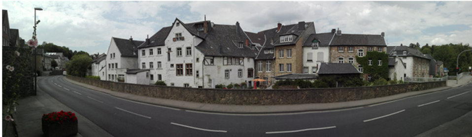
Napoleonsberg nördliche Bebauung (Rückansicht Korneliusmarkt)
