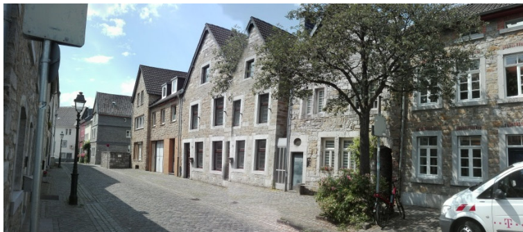
Korneliusstraße nördliche Bebauung
