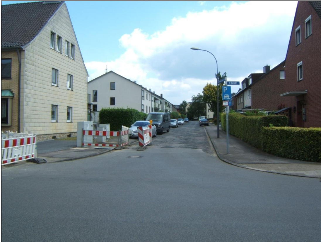
Dr.-Josef-Lamby-Straße, Knoten Ellerstraße (Blickrichtung Kolpingstraße)
