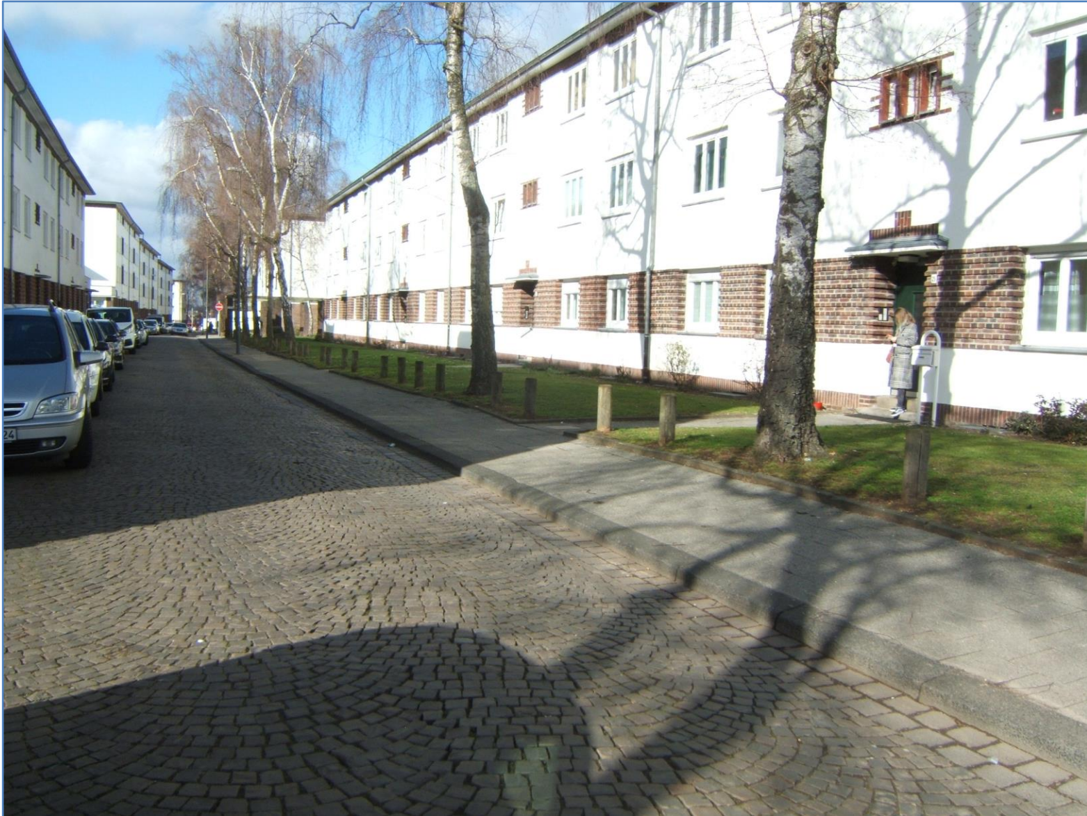
Lützowstraße, bauliche Anpassung nach Regionetz-Maßnahme
