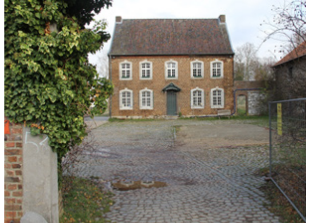
Abbildung 30: Gutshaus Branderhof Quelle: Planungsgruppe MWM
