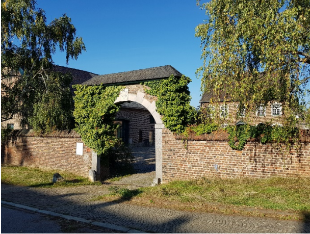
Abbildung 29: Eingangstor zum Gut Branderhof Quelle: Planungsgruppe MWM
