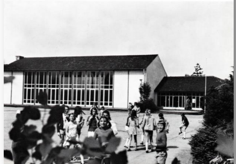
TURNHALLE RICHTERICH MIT SCHULPLATZ
