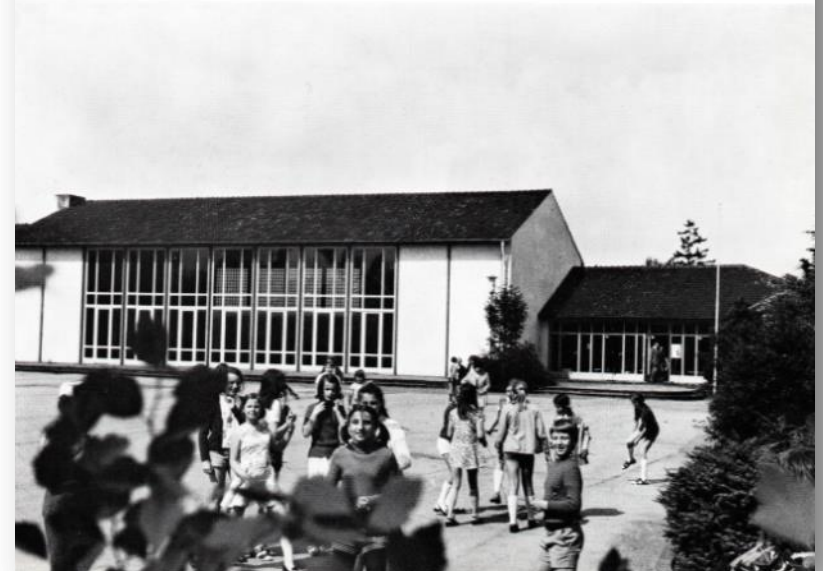
TURNHALLE RICHTERICH MIT SCHULPLATZ
