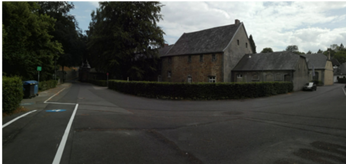
Abteigarten - Blick auf die nord-westlichen Bereich der Abtei
