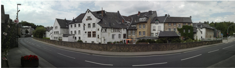
Napoleonsberg nördliche Bebauung (Rückansicht Korneliusmarkt)
