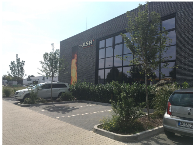
Parkplätze Restaurantbetriebe Gut-
