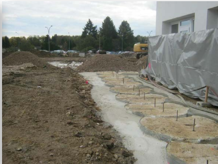
Bohrschablone von Gebäude VO, 07.11.2014
