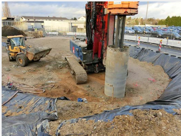
Großlochbohrungen, Sanierungszone 1, 10.12.2014
