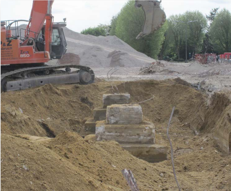
Rückbau von Gebäuden und Fundamenten
