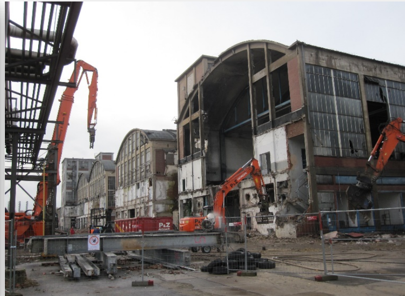
Umverlegung vorhandener Leitungen und Kanäle
