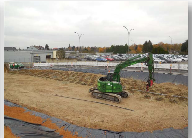
Kampfmittelbohrungen, Sanierungszone 1, 19.11.2014
