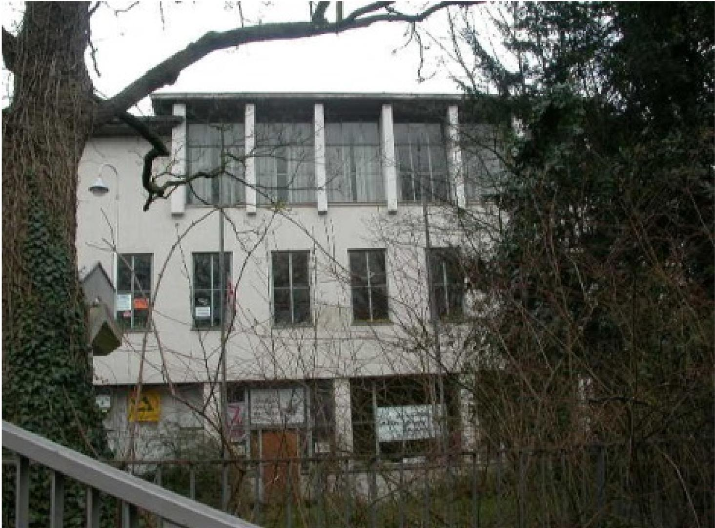
Form follows function: im Erdgeschoss große Fenster für Klassenräume, im 1. OG Einzelfenster für Büros, im 2.OG die Aula, besonders hervorgehoben und gestaltet.
