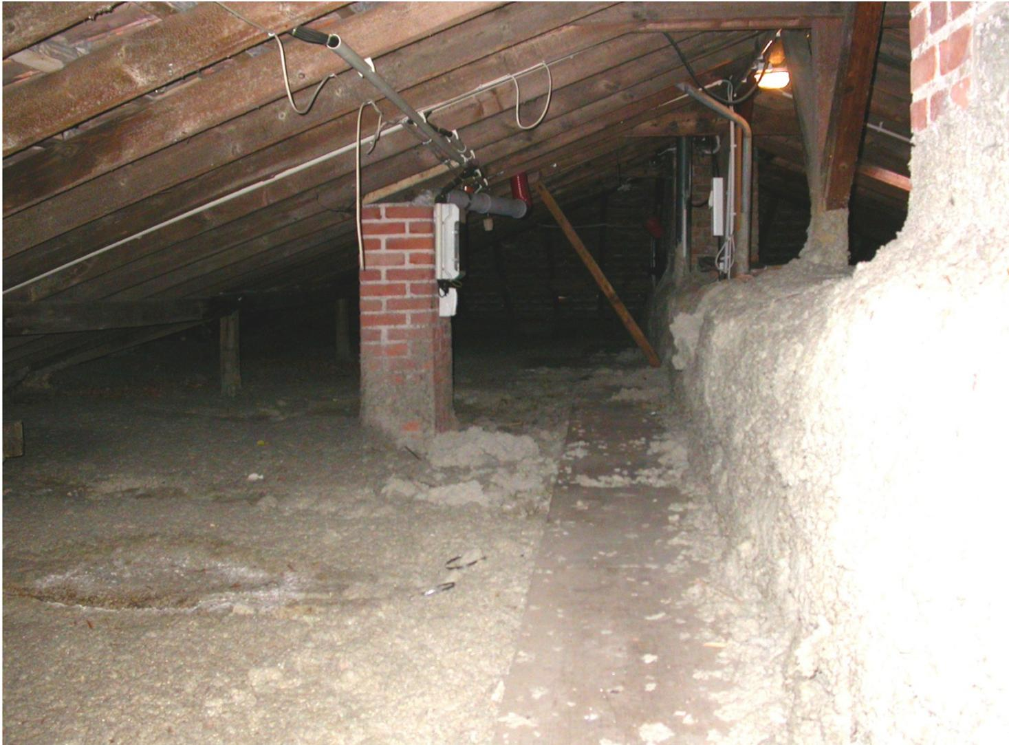
Im Speicher des Hauptdaches wurde eine 20 cm und mehr starke Einblasdämmung eingebracht.
