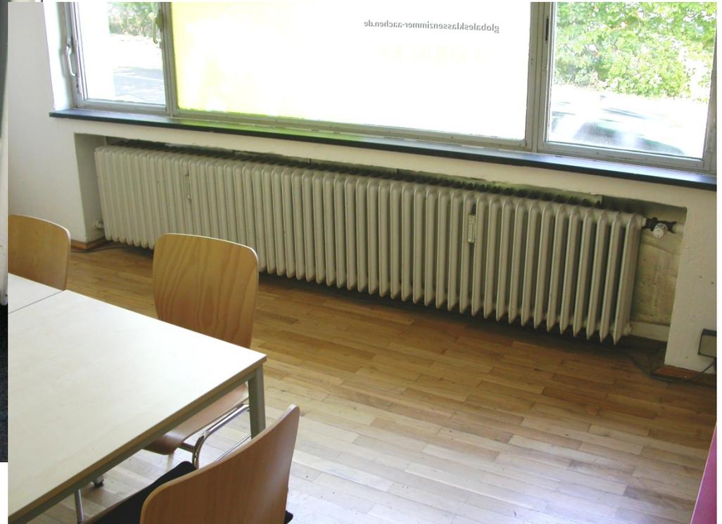
Der Abstand der Heizkörper zur Wand beträgt 0-3 cm. Um eine Innendämmung anzubringen, müssen alle Heizkörper demontiert und die Anschlüsse verändert werden.
