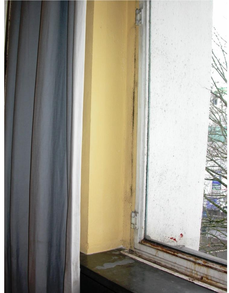
Im Seitenbau muss bei Innenfenstern auch noch die Anforderung 2. Rettungsweg berücksichtigt werden. Bei Sanierung der Stahlfenster ist die Bauphysik genau zu untersuchen.
