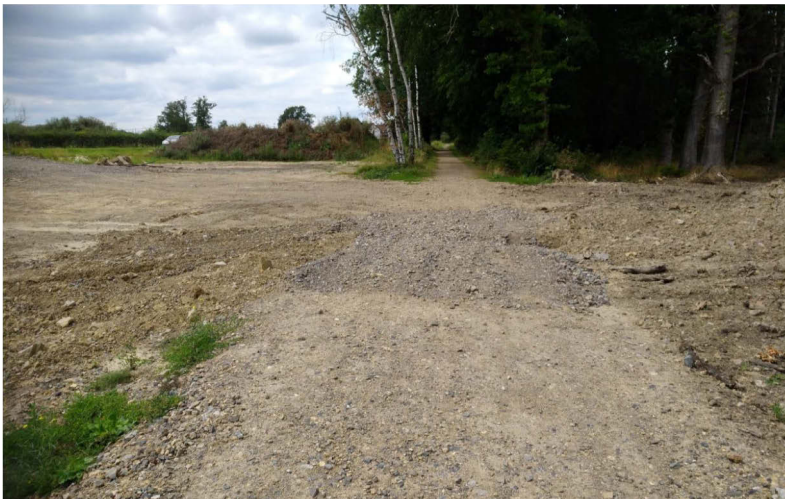
Station 1+530, bei Stich Richtung Deltourserb
