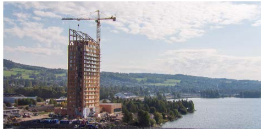
Das Holzhaus Mjøstårne, benannt nach dem Fluss, an dem es errichtet wurde, ist 85,4 Meter hoch. ©Mjøstårne
