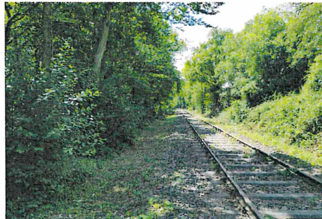
Blick in Richtung Walheim
