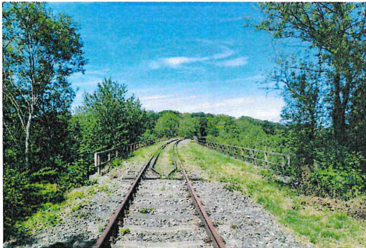
Blick auf das Falkenbachviadukt
