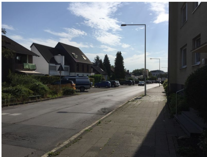
Merowinger Straße – zwischen „Am Weberhof“ und Emmastraße. Auf der Seite der Senkrechtparkstände sind 3 neue Baumstandorte geplant.
