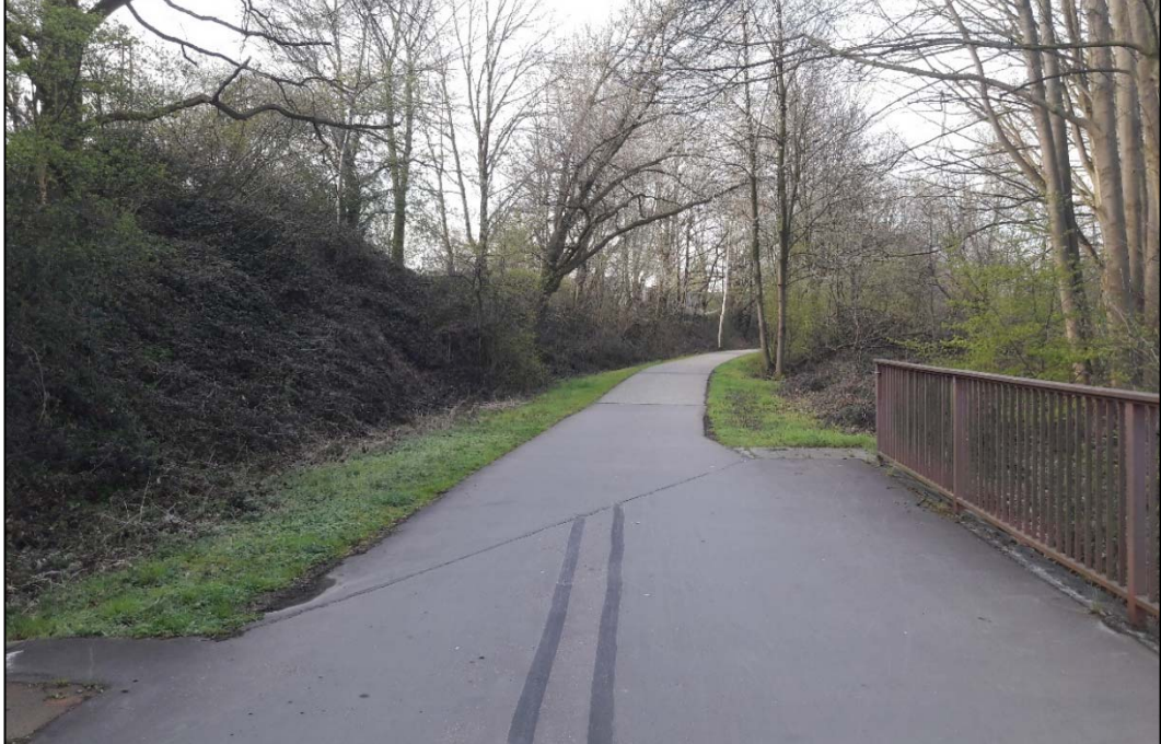
Abb. 6: Ausbau nach links ab Autobahnbrücke
