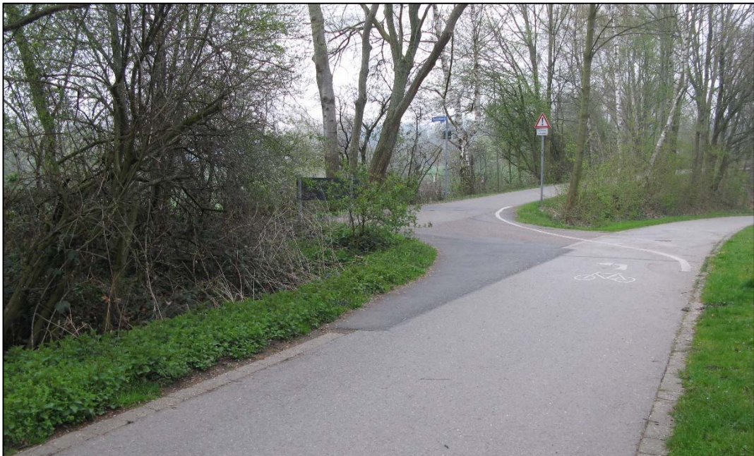
Abb. 5: Verbreiterung der Kurvensituation im Übergang zu Abschnitt 7 durch Wegausbau nach links auf etwa 15 m Strecke in Gebüsch und frische Ruderalflur
