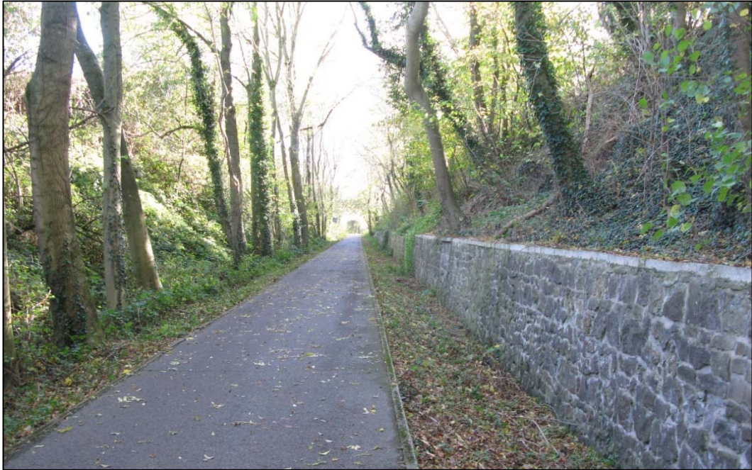
Abb. 16: Ausbau nach rechts vor Stützmauer in Abschnitt 27.
