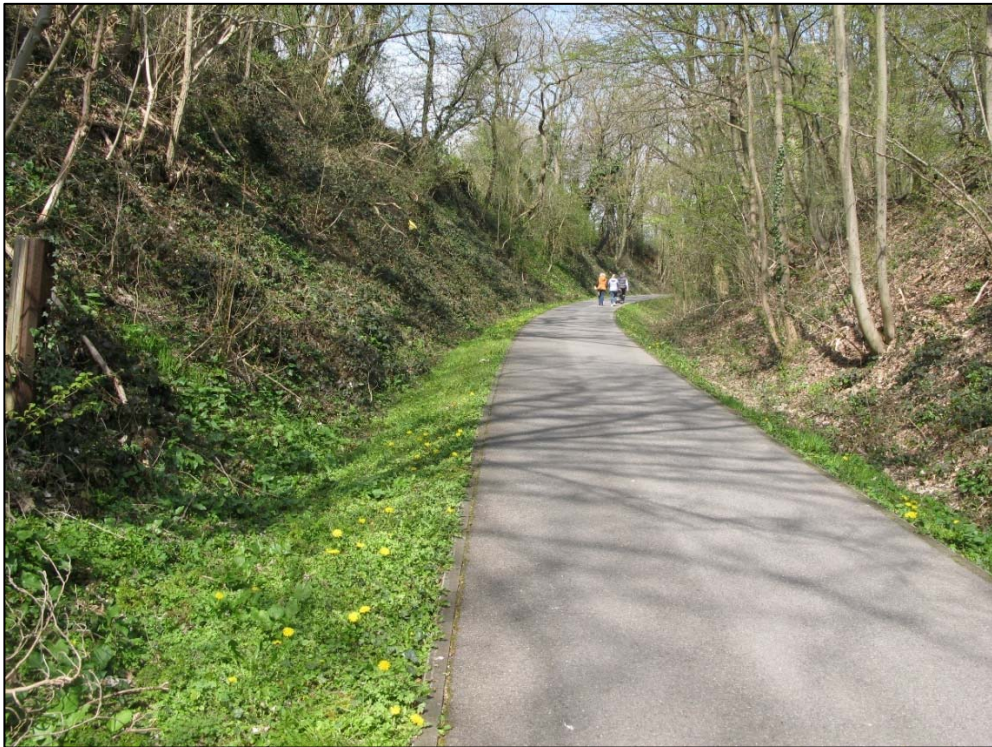
Abb. 12: Ausbau links in Seitengraben mit Ruderalflur
