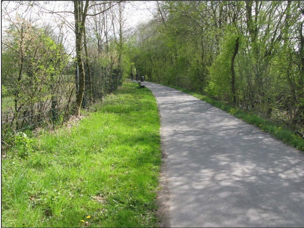
Abb. 13: Ausbau nach links in Bankett im Traufbereich von Gehölzen unter Beschränkung der Ausbaubreite auf 3 m zuzüglich Bankett am Ende von Abschnitt 22.
