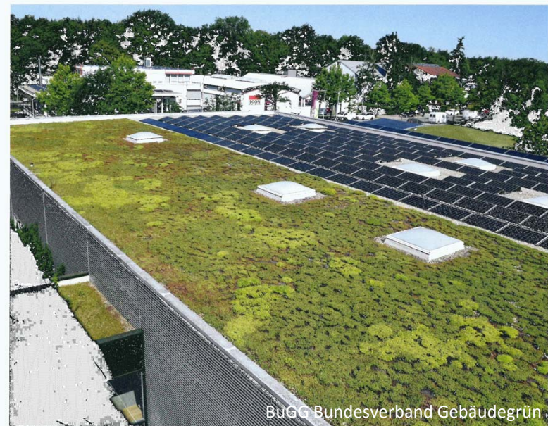
Abb. 60: Objektbeispiel in Freiburg im Breisgau: Auf einer Dachfläche sind Solar-Anlage (Kiesdach) und Dachbegrünung klar voneinander abgegrenzt.
