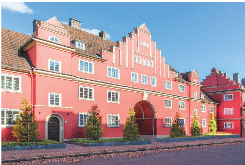
Abbildung 15: Sanierte Gebäude in der Joseph-von-Görres-Straße. Fotonachweis: NRW.BANK/Christian Lord Otto
