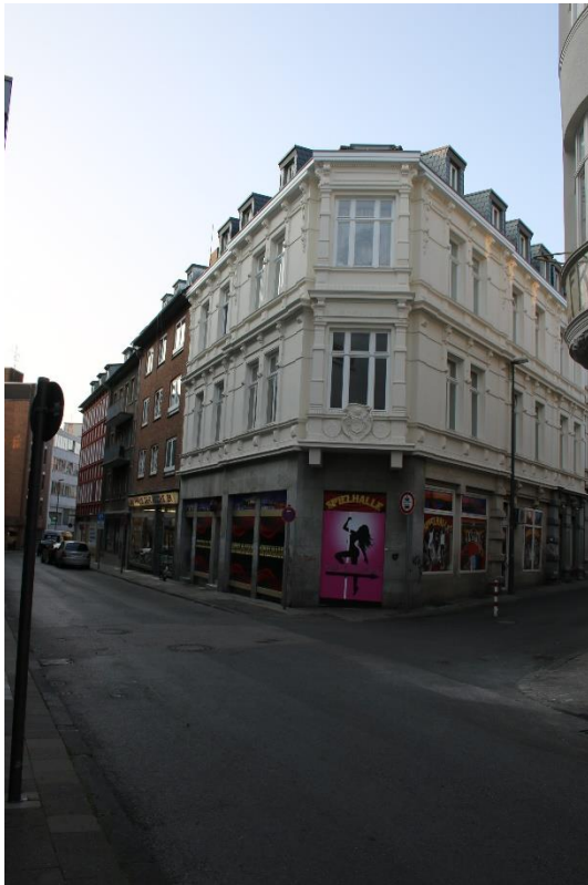
Abbildung 10: Mefferdatisstraße 8 Teilsaniertes Gebäude Quelle Eigene Aufnahme
