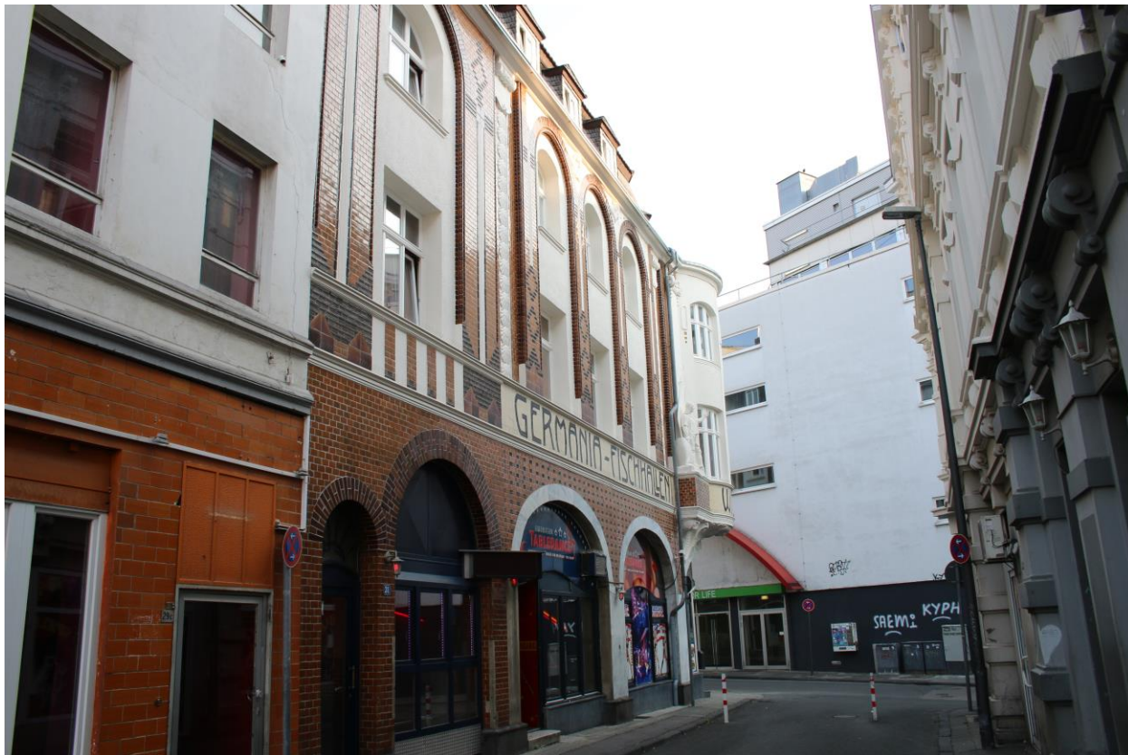
Abbildung 8: Antoniusstraße, Blickrichtung Mefferdatisstraße: Saniertes Eckgebäude und Blick auf leerstehendes, ehemaliges Kaufhaus Quelle: Eigene Aufnahme
