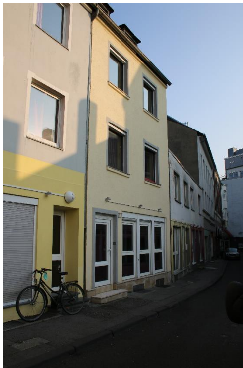
Abbildung 16: Antoniusstraße 25 und 27(links): Instandgehaltene Gebäude durch Eigentümer und Pächter als gleichzeitigen Betreiber der Nutzung Quelle: Eigene Aufnahme
