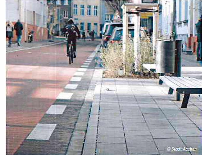
Die Fahrgasse der Radfahrenden wird beidseitig durch unterbrochene Linien begrenzt. Neben Parkplätzen wird zum Schutz vor aufschlagenden Türen ein Sicherheitsraum eingerichtet. Die Optimalbreite der Fahrgasse von 4,50 m ist auf das gefahrlose Begegnen von einem Pkw mit zwei nebeneinanderfahrenden Fahrrädern ausgelegt.
